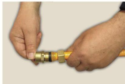
6. Обжимаем фитинг гаечным ключем
