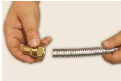
3. Обжимаем фитинг гаечным ключем
